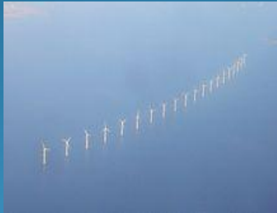
Windanlagen auf dem Meer
